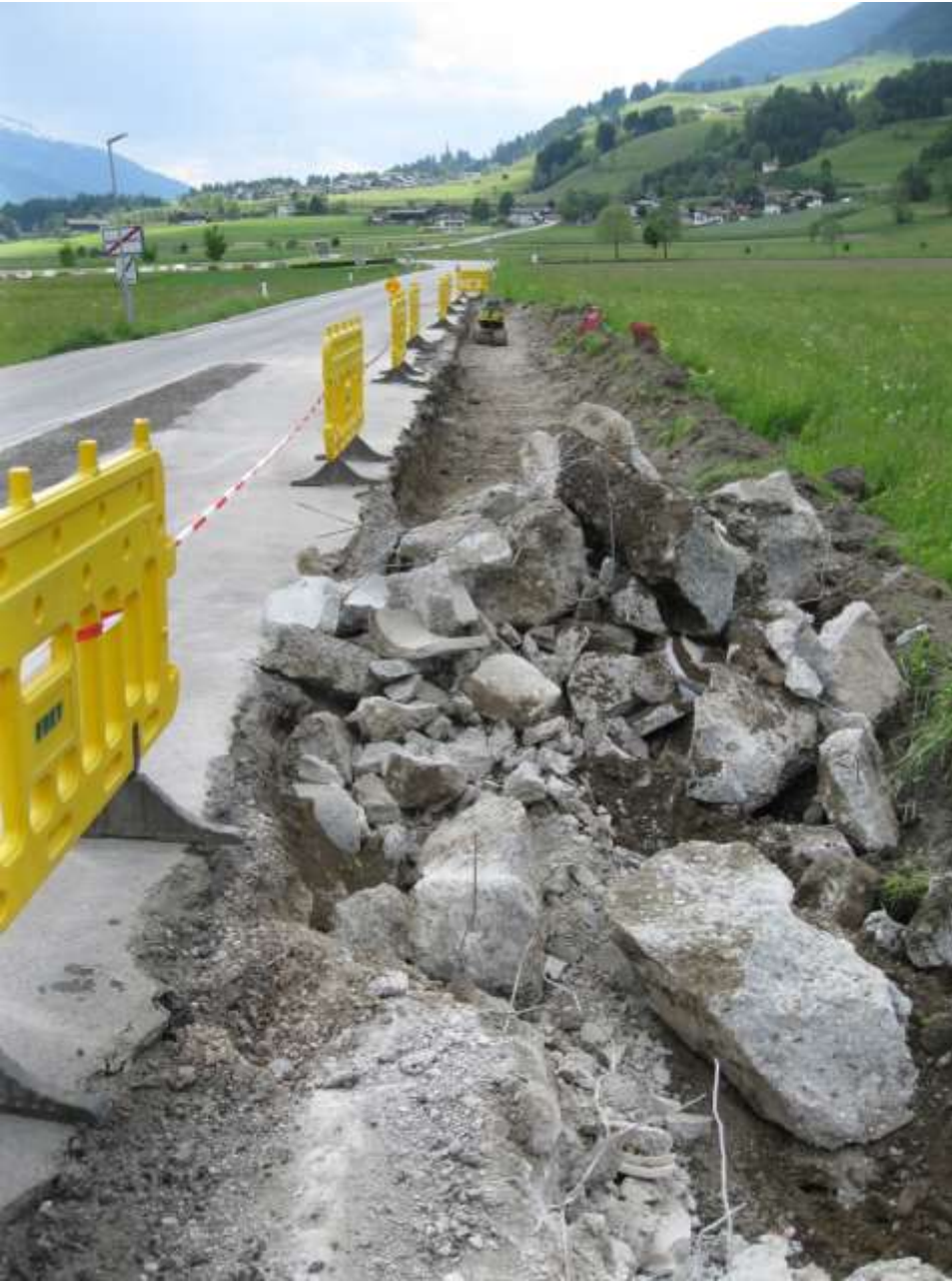
Alte Verrohrung vom Pulverbach wurde ausgebaut
