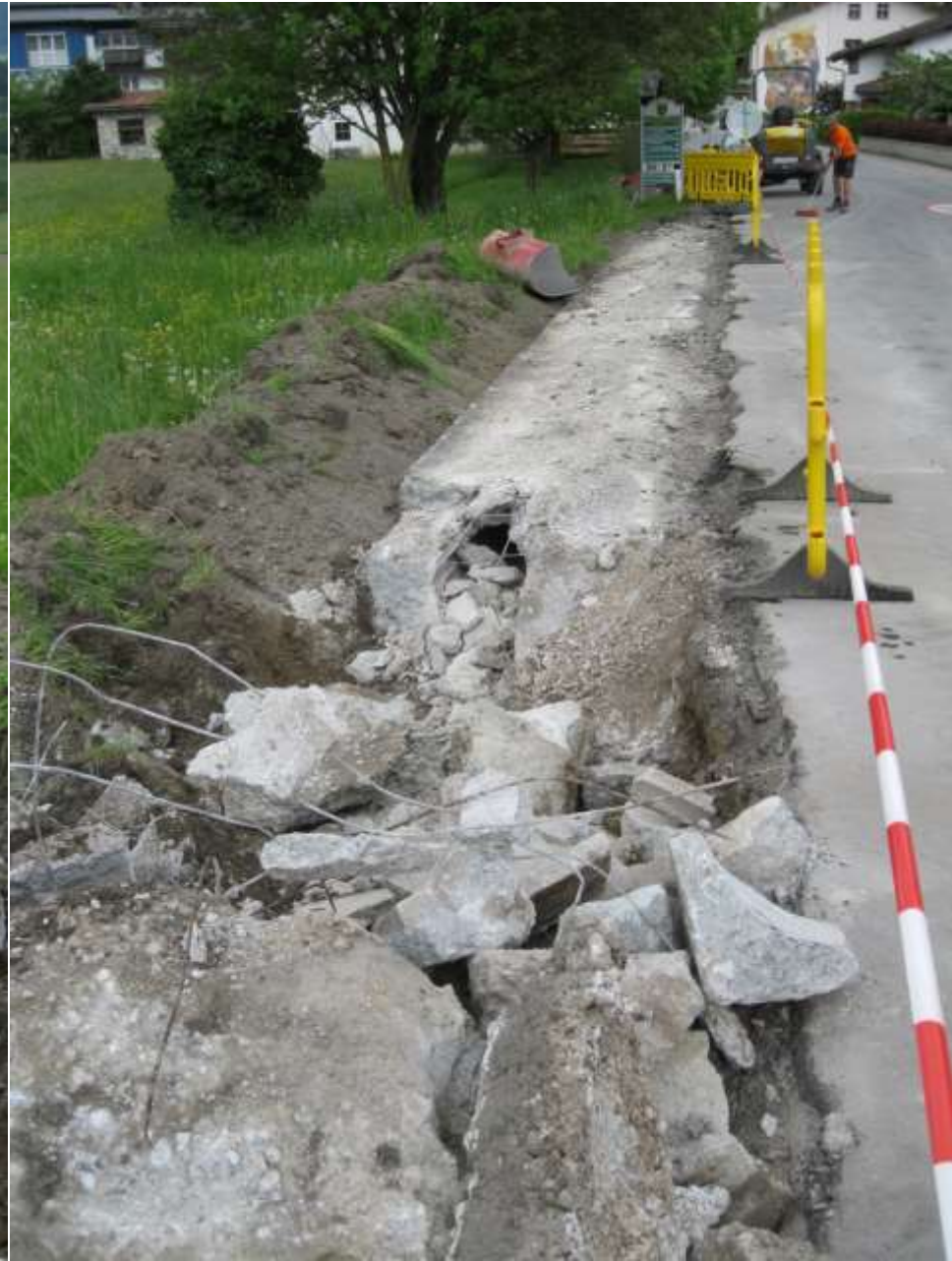
Alte Verrohrung vom Pulverbach wurde ausgebaut
