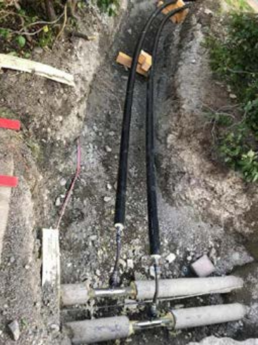
Das Fernwärmenetz wird um 6 Anschlüsse (185 kW) erweitert
