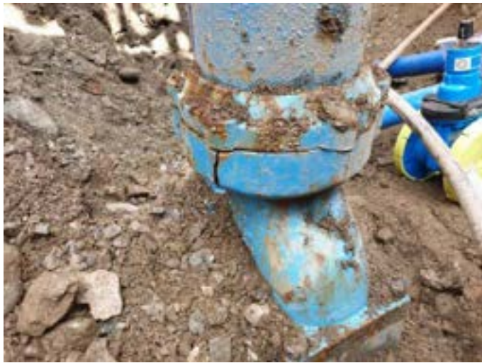
Hydrant bei Moser (Brugger) war undicht und wurde erneuert und versetzt
