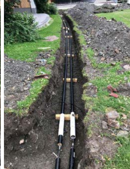
Das Fernwärmenetz wird um 6 Anschlüsse (185 kW) erweitert
