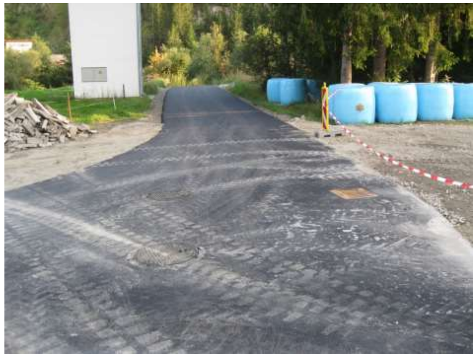
Neue Asphaltdecke nach Verlegen des Oberflächenwasserkanals Unterdörfli
