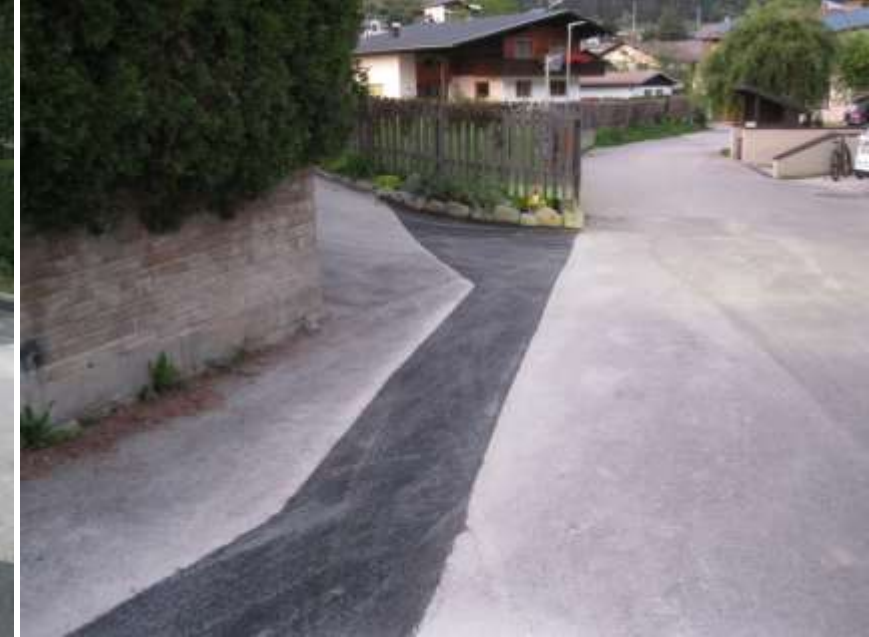
Asphaltierung nach Verlegen der LWL Verrohrung und notwendiger Verbesserungen der Schachtabdeckungen
