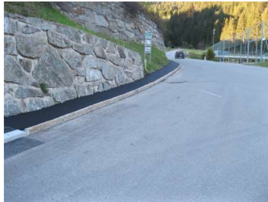
Asphaltierung nach Verlegen der LWL Verrohrung und notwendiger Verbesserungen der Schachtabdeckungen
