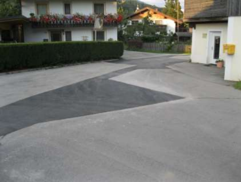
Asphaltierung nach Verlegen der LWL Verrohrung und notwendiger Verbesserungen der Schachtabdeckungen
