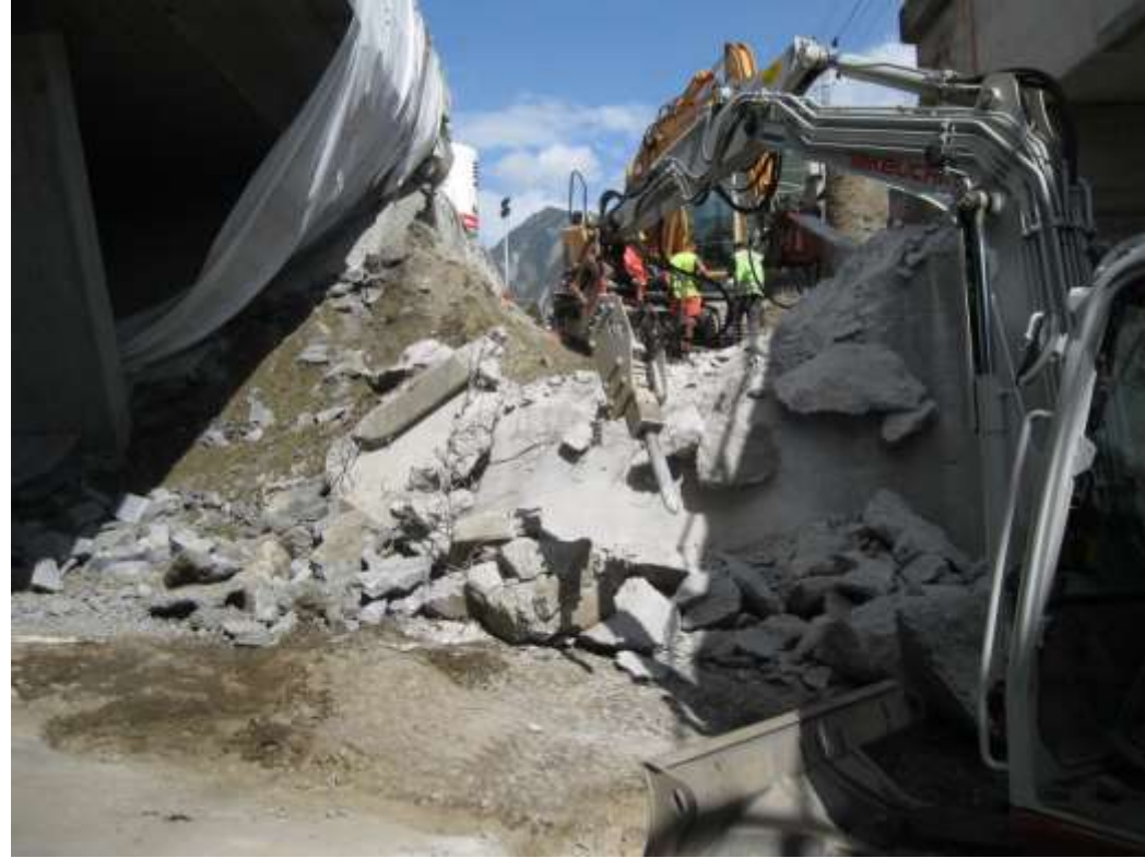
Bahnhaltestelle Abfaltersbach wird gebaut
