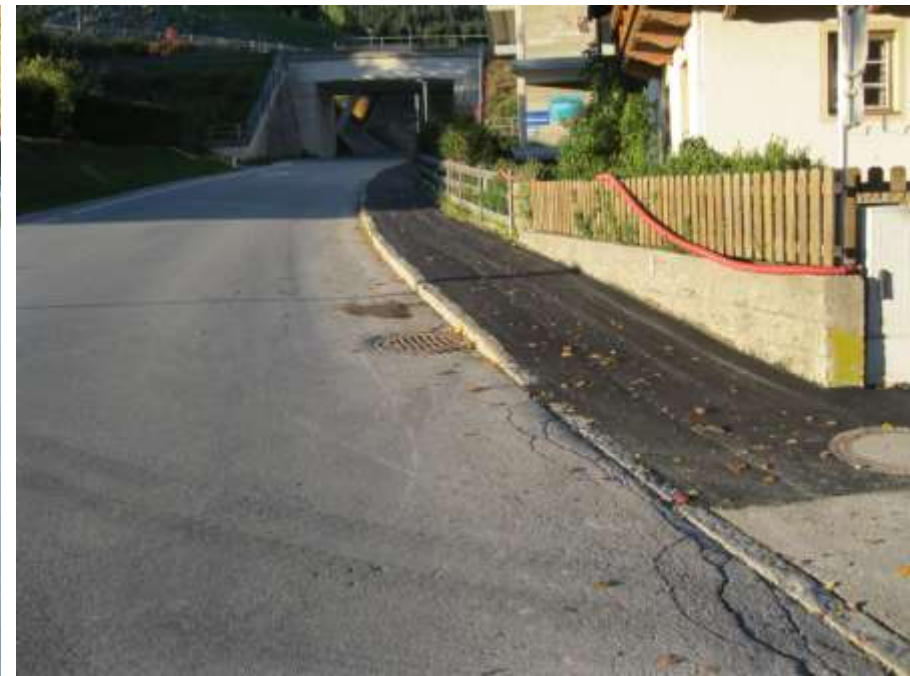
Asphaltierung nach Verlegen der LWL Verrohrung und notwendiger Verbesserungen der Schachtabdeckungen
