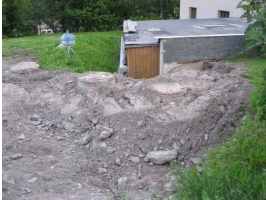
Kanalschächte erhöht, Fernwärmenetz erweitert
