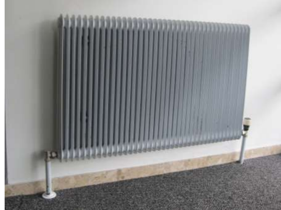
Thermostatventile ausgetauscht
