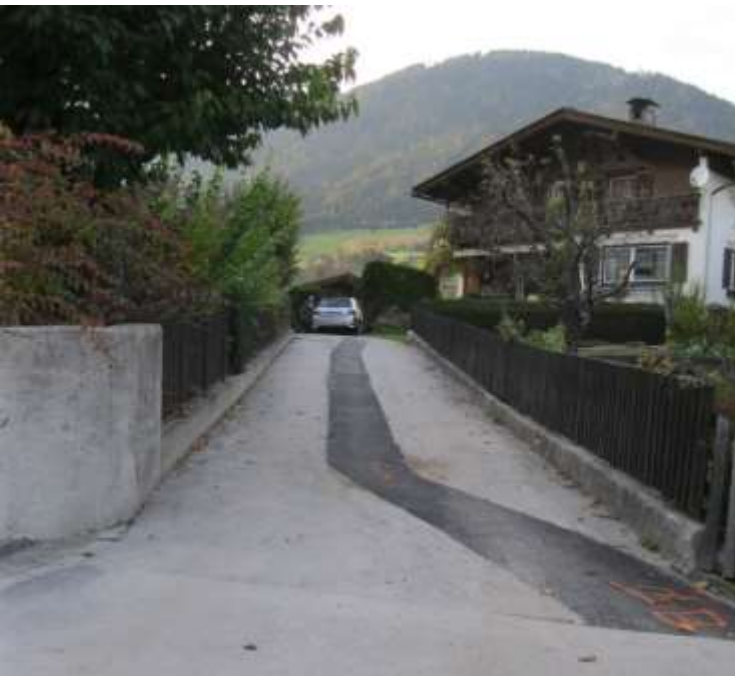
Asphaltierung nach Verlegen der LWL Verrohrung und notwendiger Verbesserungen der Schachtabdeckungen
