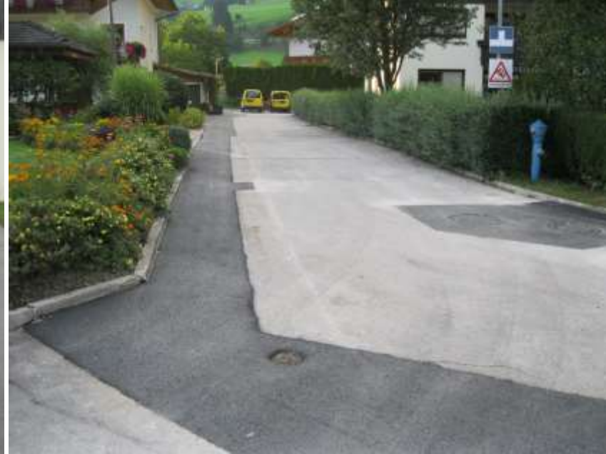
Asphaltierung nach Verlegen der LWL Verrohrung und notwendiger Verbesserungen der Schachtabdeckungen
