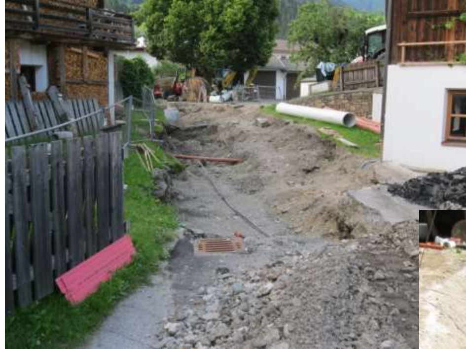
Vergrößern des Oberflächenwasserkanals Unterdörfli 06.07. – 21.08.2020
