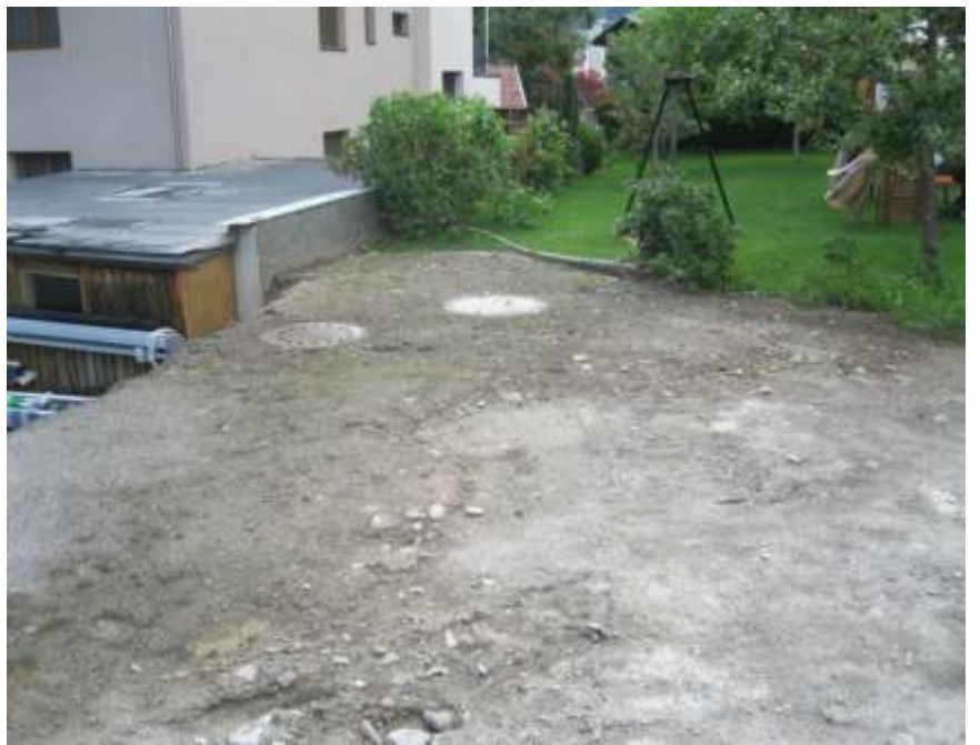
Kanalschächte erhöht, Fernwärmenetz erweitert
