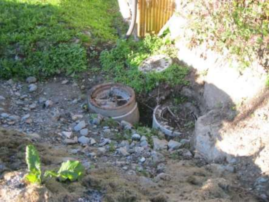
Kanalschächte erhöht, Fernwärmenetz erweitert
