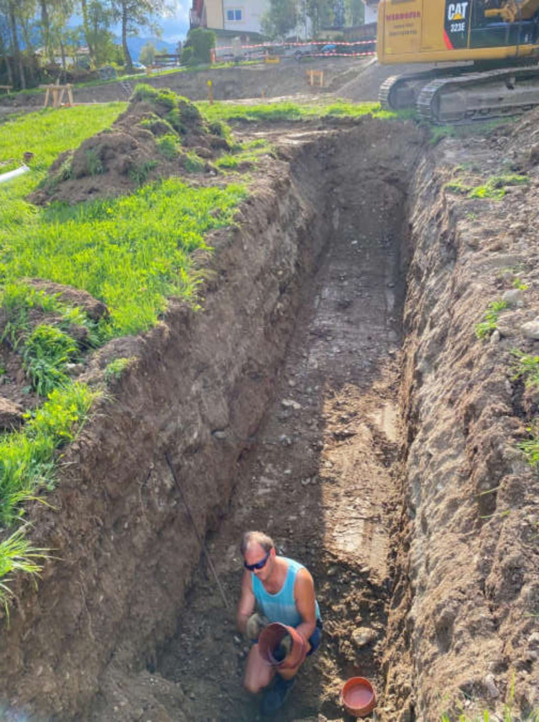
Kanal, Wasserleitung und Glasfaser für Neubau Christian Moser
