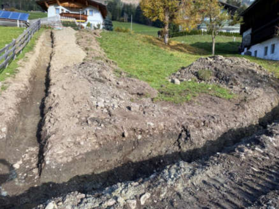
Verlegung der Tinetz- und Straßenbeleuchtungskabel in Einöd, sowie die LWL- Verbindung Richtung Panner
