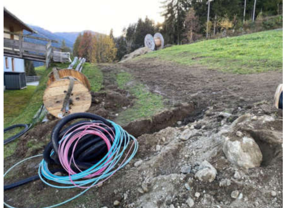
Verlegung der Tinetz- und Straßenbeleuchtungskabel in Einöd, sowie die LWL- Verbindung Richtung Panner
